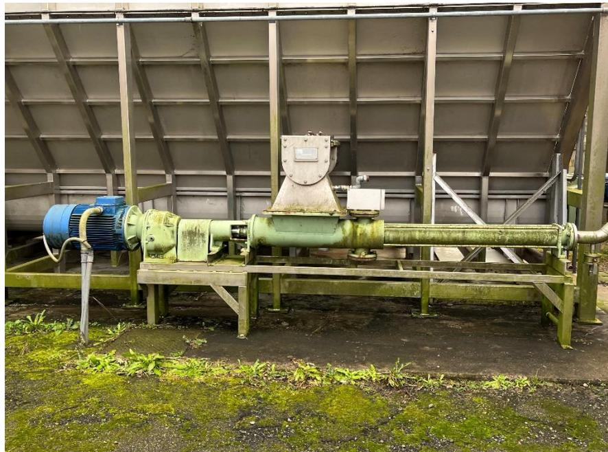
**Pompa di estrazione del fango disidratato: dismettere**
