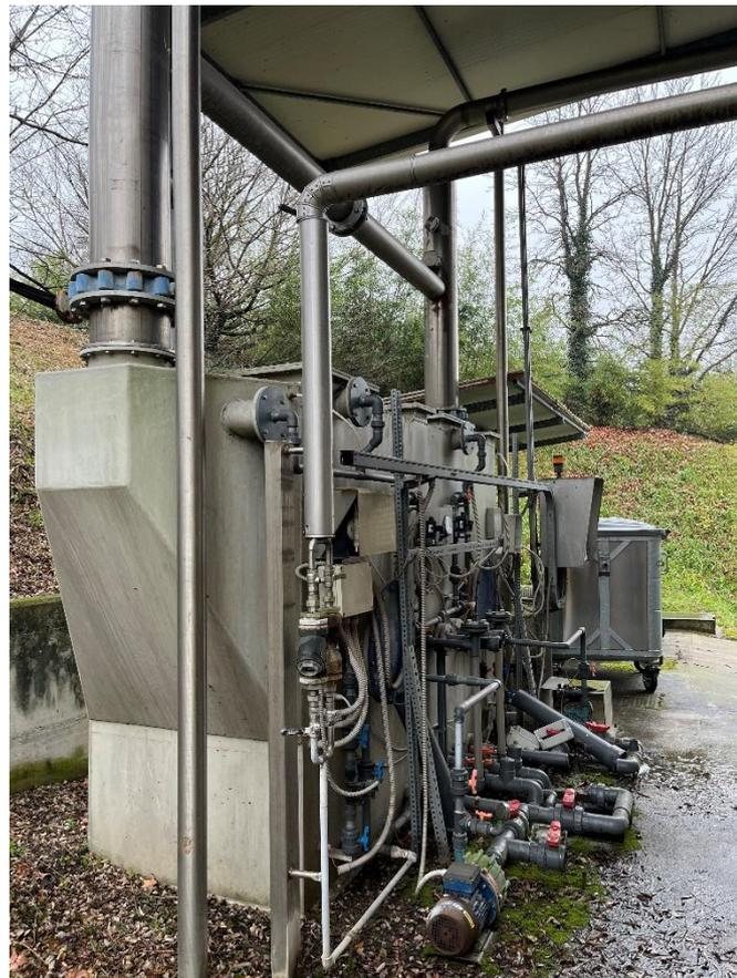
**Impianto chimico fisico acido-base per il lavaggio dei fumi incondensabili, con tubazione di alimentazione dell'acqua. Interamente da dismettere, tranne la tettoia che resta in loco.**
