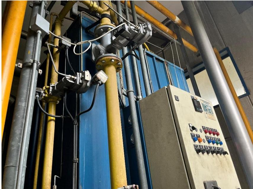
**Caldaia Babcock Wanson interamente da rimuovere con relativo quadro elettrico**
