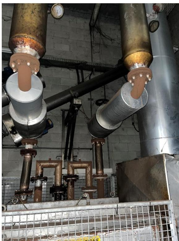
Tubazioni olio diatermico e batteria di scambio.
