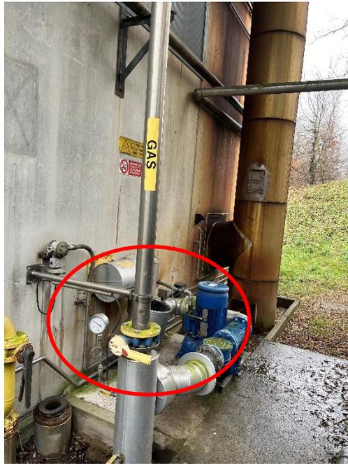
**Soffiante del biogas da dismettere.**
