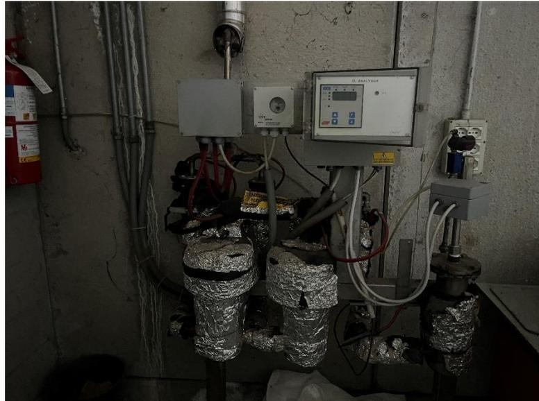
**Strumentazione di controllo dell'ossigeno: da dismettere**
