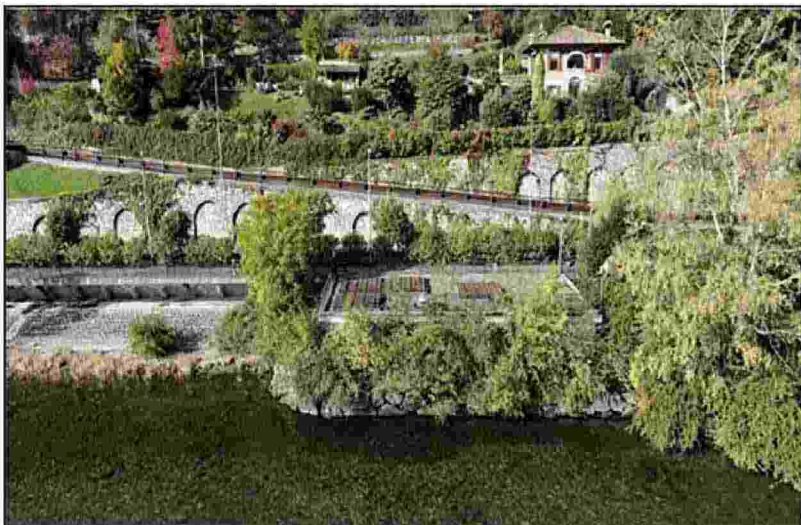
Potabilizzatore "Menaggio" (Menaggio) - Altra infrastruttura strategica per il sistema di connessione intercomunale
